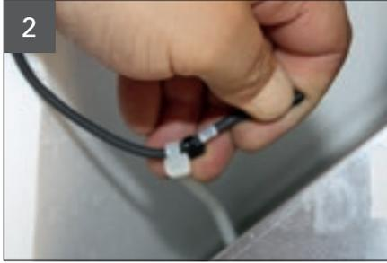
Ausbau Zulufttemperaturfühler (T2):
