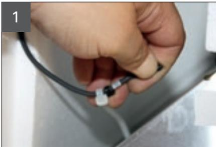
Zuerst muss der Kabelbinder mit dem der Zulufttemperaturfühler (T2) im Wärmetauscher (ca. 20igste Lamelle) fixiert ist herausgezogen werden.
