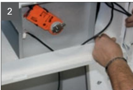
Kunststoffabschluss der Kondensatwanne vorsichtig aus den EPS Kern des Lüftungsgerätes ziehen.
