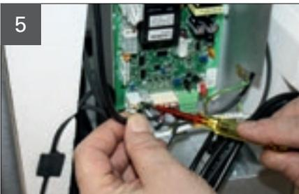
Klemme J14 - Feuchtesensor Abluft lösen.
