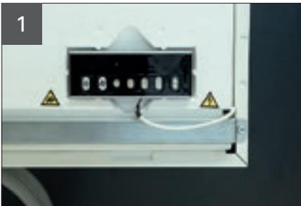
Das Bedienteil aus dem EPS Frontdeckel entnehmen.
