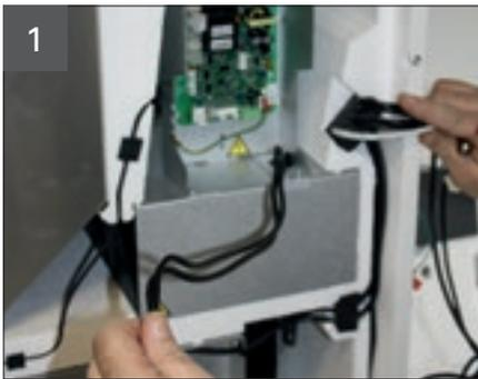
Nachdem alle Anschlüsse auf der Steuerplatine wie in Kapitel 4 Schritt 1-9 beschrieben gelöst wurden, kann mit der Demontage des Ventilators Zuluft begonnen werden.
