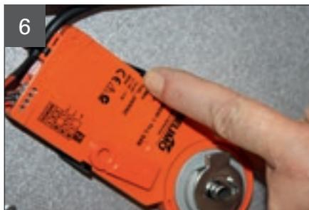
Seitliche Befestigungsclips lösen.
