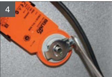
Befestigungsschraube lösen (Schraubenschlüssel SW8).
