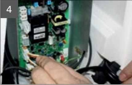
Klemme J4 - Signalleitung Zuluftventilator (0-10V) lösen.
