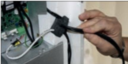
Anschließend sind die entsprechenden Kabel aus der Kabeldurchführung zu lösen.
