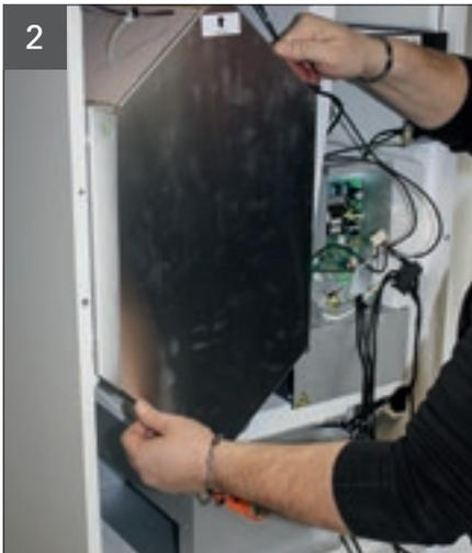
Den Wärmetauscher vorsichtig aus dem EPS Gehäuse des Lüftungsgerätes ziehen.
