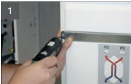
Zuerst müssen die 3 Befestigungsschienen entfernt werden, dazu die je 2 Imbusschrauben (HOP 2) lösen und die Schienen abnehmen.
