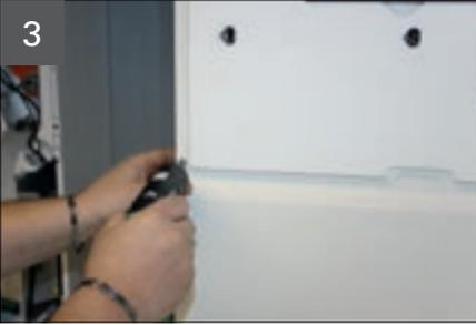
Die beiden Befestigungsschrauben (Kreuzschlitz PH 2) der unteren Frontblende lösen.
