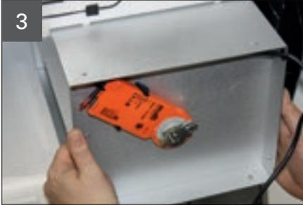
3 Ventilatorgehäuse vorsichtig aus den EPS Kern des Lüftungsgerätes ziehen.
