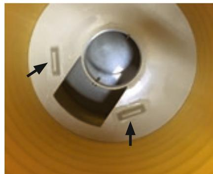
**Es ist darauf zu achten, dass der Bügel zur Auftriebssicherung in der Schachtwand einrastet, bevor die Anlage wieder befüllt wird.**
