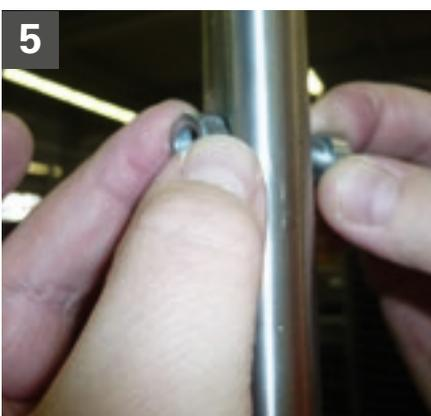
5 Einstellen der Teleskopstange des Betriebsrohres auf die Schachthöhe mittels vorhandener Verschraubung. Der Griff soll zur besseren Erreichbarkeit direkt unter dem Schlammmeimer liegen.
