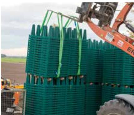
Aufgrund der Stapelhöhe von 2,55 m empfiehlt sich für das einfache Abheben und Verarbeiten der Grundelemente das Vereinzeln der beiden gestapelten Paletten. Dafür empfehlen wir die Verwendung von Hebegurten.
