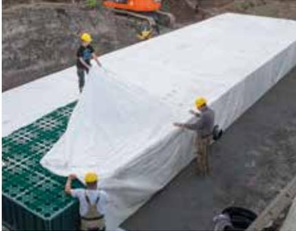
Rigofill-Anlagen für die Versickerung sind vollständig mit Vlies (z.B. RigoFlor) zu umhüllen. An den Stößen sind ausreichende Überlappungen (mind. 50 cm) herzustellen, damit kein Verfüllmaterial in die Anlage gelangen kann. Rohreinleitungen sind durch kreuzförmiges Einschneiden des Vlieses sanddicht herzustellen.
