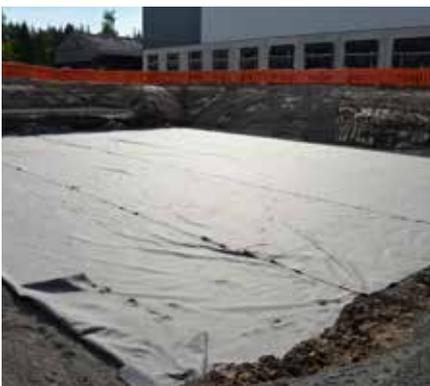
Die gesamte Rigole ist mit einem geeigneten Rigolenvlies z.B. RigoFlor zu umhüllen. Vor der Verlegung der Blöcke ist das Vlies auf dem Planum auszulegen. Das Vlies muss seitlich genügend Überstand haben, damit anschließend die gesamte Anlage umhüllt werden kann.
