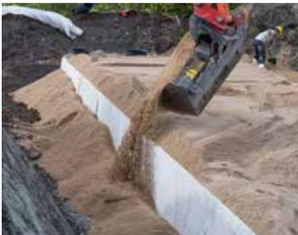
Die Blockverbinder arretieren die einzelnen Rigofill ST-A Blöcke und verhindern weitgehend ein seitliches Verrutschen des Rigolenkörpers beim Hinterfüllen. Für die Hinterfüllung ist nichtbindiger, nicht gefrorener Erdbaustoff mit einer max. Korngröße von 32 mm zu verwenden. Das Verfüllmaterial ist allseitig gleichmäßig einzubringen und in Lagen von max. 30 cm mittels leichtem oder
