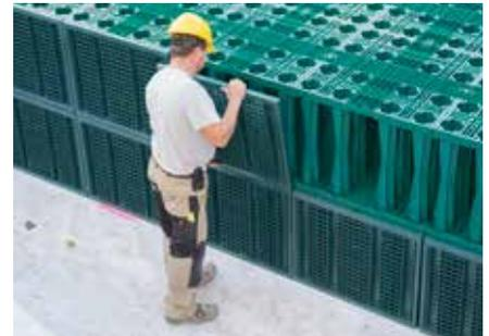
Je nach den örtlichen Gegebenheiten kann die Anbringung der Seitenwandgitter bereits außerhalb der Baugrube vorgenommen werden.
