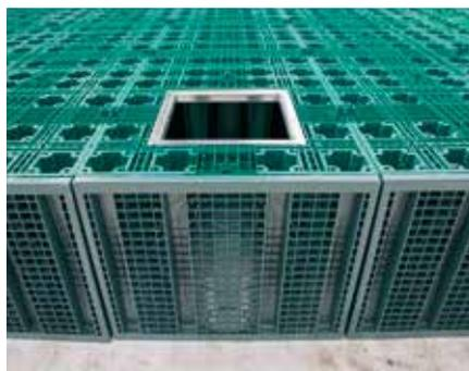
Dieses Schachtunterteil ist an der geplanten Position im Rigolenraster zu setzen. Dabei ist darauf zu achten, dass die Öffnung mit Metallrahmen nach oben zeigt. Mit den benachbarten Rigofill ST Blöcken ist mittels Blockverbinder die Verbindung herzustellen.
