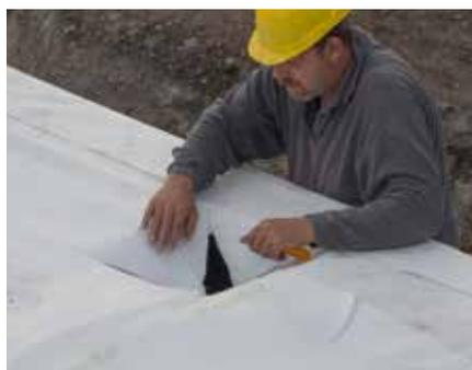
Unabhängig von der Lagenanzahl bilden die Muffenkonen den Übergang zu den Aufsetzrohren. Zweckmäßigerweise werden die Muffenkonen erst nach Fertigstellung der obersten Rigolenlage auf die Schachtöffnungen aufgesetzt. Vor dem Aufsetzen der Muffenkonen ist die gesamte Rigole inkl. Schächte mit dem Umhüllungsvlies abzudecken. An den quadratischen Öffnungen ist das Vlies auszuschneiden.
