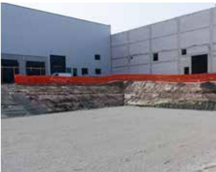
Für die Verlegung der Rigofill ST Blöcke ist grundsätzlich ein waagerechtes, ebenes und tragfähiges Auflager herzustellen. Dazu ist auf die Baugrubensohle eine ca. 10 cm starke Ausgleichsschicht, vorzugsweise aus Splitt (z.B. 2/5 mm), Kies oder Sand aufzubringen. Diese Schicht ist plan abzuziehen und zu verdichten.
