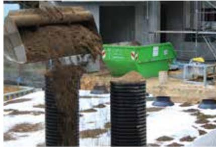
Funktion Bauzeitenabdeckung bei Verfüllung
