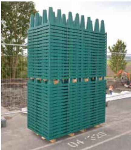
Rigofill ST kann im Freien gelagert werden. Die Lagerzeit im Freien darf jedoch **ein Jahr** nicht überschreiten, wobei das Material vor direkter Sonneneinstrahlung zu schützen ist (z. B. durch Lagerung im Schatten oder Abdecken mit heller, lichtundurchlässiger Folie).
