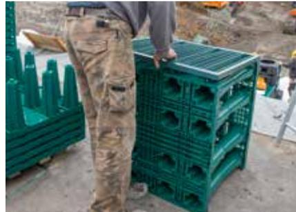
Je nach den örtlichen Gegebenheiten kann die Anbringung der Seitenwandgitter bereits außerhalb der Baugrube vorgenommen werden.
