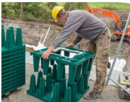
Der Schachtaufbau erfolgt lagenweise und wächst mit dem Baufortschritt der Rigole. Der Einbau der untersten Lage des QuadroControl ST Schachtes beginnt immer mit dem Zusammenstecken des Halbelementes und des Schachthalbelementes.
