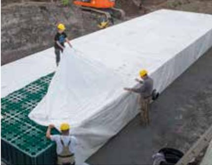
Rigofill-Anlagen sind vollständig mit Vlies (z.B. RigoFlor) zu umhüllen. An den Stößen sind ausreichende Überlappungen (mind. 50 cm) herzustellen, damit kein Verfüllmaterial in die Anlage gelangen kann. Rohreinführungen sind durch kreuzförmiges Einschneiden des Vlieses sanddicht herzustellen.
