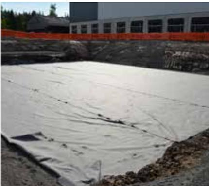
Die gesamte Rigole ist mit RigoFlor Rigolenvlies zu umhüllen. Vor der Verlegung der Blöcke ist das Vlies auf dem Planum auszulegen. Das Vlies muss seitlich genügend Überstand haben, damit anschließend die gesamte Anlage umhüllt werden kann.
