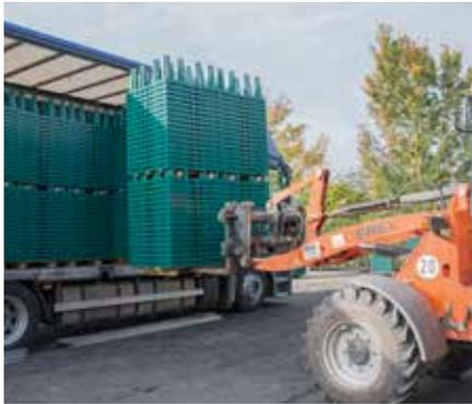
Rigofill ST Blöcke werden auf Paletten (Grundfläche 1,60 m x 0,80 m) gestapelt geliefert. Der Inhalt umfasst 68 Halbelemente für 34 Blöcke. Üblicherweise sind werkseitig 2 Paletten übereinander gestapelt. Seitenwandgitter, Zwischen-gitter und Deckenplatten (nur für Halbblöcke erforderlich) sind auf eigenen Paletten gepackt.
