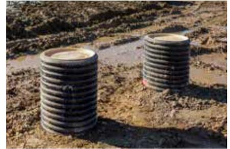
Bauzeitenabdeckung der Aufsetzrohre
