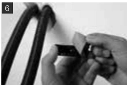
Bei der Montage der Schiene müssen die Hinweise gem. Verarbeitungsanleitung Klebeband (s. Seite 5) beachtet werden. Bei Bedarf kann die Schiene durch Verschrauben fixiert werden.
