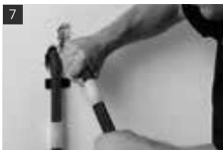
An der Außenwand wird das herausstehende Rohr anhand der zugfesten Muffe mit dem weiterführenden Rohr verbunden. Das Rohr wird mit der Schiene an der Außenwand befestigt.
