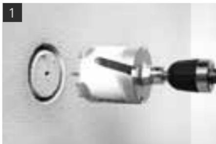
Für das Setzen der Dosen dienen Dosensenker bzw. Bohrkronen. Beim Bohren ist darauf zu achten, dass keine in der Wand liegenden Leitungen oder Rohre beschädigt werden.
