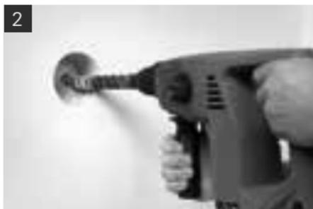
Beim Bohren des Mauerdurchbruches für das FFKu-ReMo click ist zu beachten, dass die Position der Bohrung mit der Position der Rückwandeinführung der luftdichten ReMo UP-Dose übereinstimmt.
