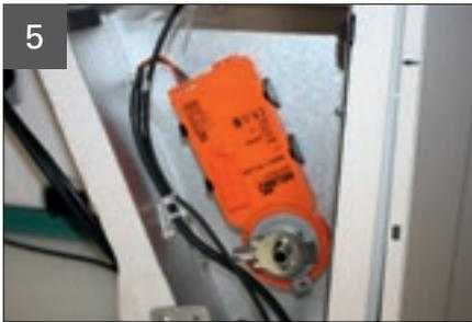
Magnet an Ausrastposition (Kennzeichnung: „magnetic gear release“) des Antriebs setzen (Magnet ist im Lieferumfang des Ersatz-Antriebs enthalten).
