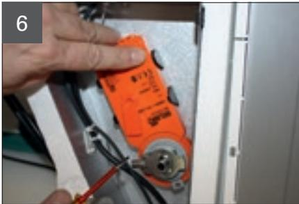
Seitliche Befestigungsclips lösen.
