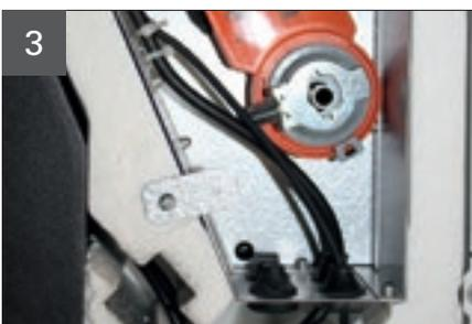
Kabel des Stellantriebes entfernen.
