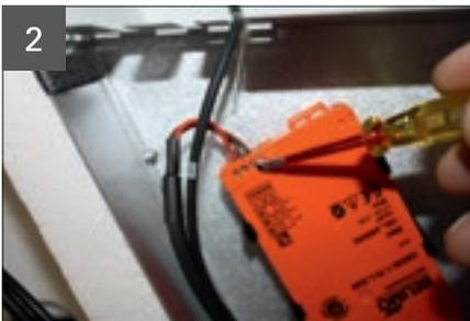
Anschlusskabel am Stellantrieb lösen
