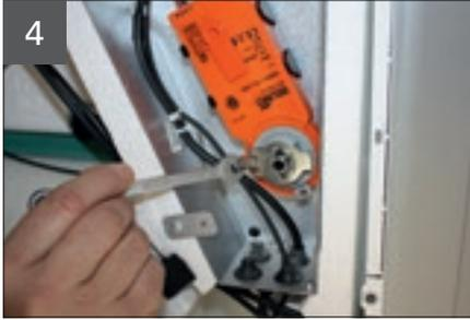
Befestigungsschraube lösen (Schraubenschlüssel SW8).
