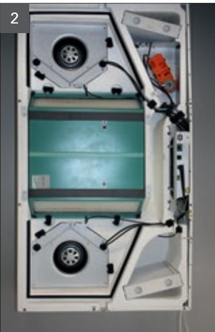
Alle 4 Temperaturfühlerkabel, ausgehend von der Platine ausbauen.
