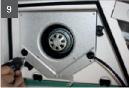
Zuerst müssen die 6 Schrauben am Frontdeckel des Ventilatorgehäuses entfernt werden (Trox T20).
