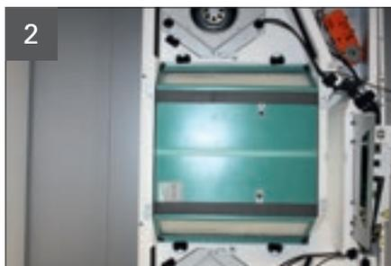
Aufkleber kennzeichnen die Einbaurichtung des Wärmetauschers.
