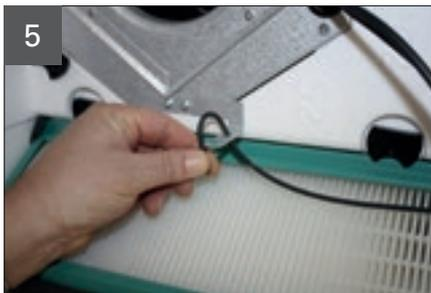
Temperaturfühler aus der Halterung am Ventilator ausfädeln.
