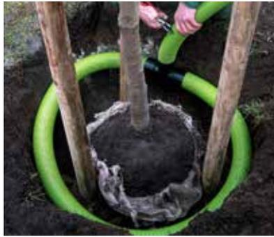
Durch einen zusätzlichen Rohrabschnitt wird eine Verbindung zwischen Ringleitung und Oberfläche hergestellt.
