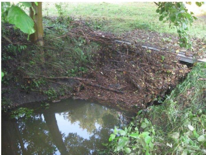
Abbildung 12: Verlegung an Einläufen von Verrohrungen und Durchlässen durch Geschwemmset in Außengebietsabflüssen (Grüning und Pecher 2020)
