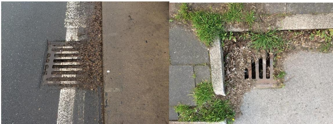
Abbildung 45: Beispiele durch Verlegung beeinträchtiger Straßenabläufe (Grüning und Pecher 2020)
