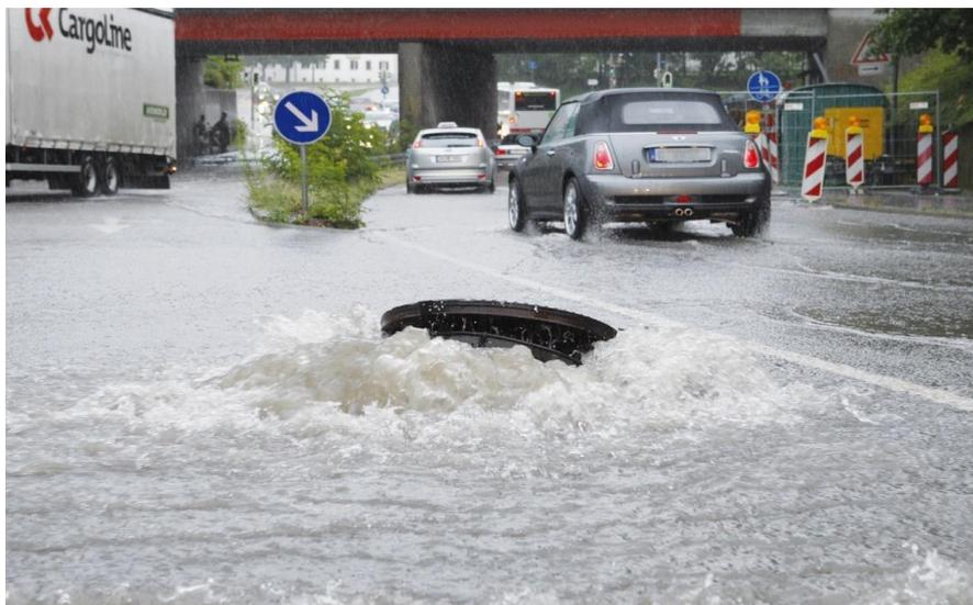
Abbildung 6: Überflutung durch Starkregen mit Wasseraustritt am Schacht (Günthert et al. 2018)
