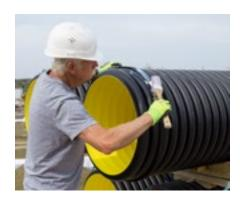
Das Schachtaufsetzrohr wird mit der Doppelsteckmuffe und den beiden Dichtringen auf den Grundschacht aufgesetzt. Dazu sind die Profildichtringe jeweils in das zweite Wellental zu montieren. Nun die Dichtringe und die Innenflächen der Doppelsteckmuffe mit Gleitmittel von FRÄNKISCHE gleichmäßig bestreichen (keine Öle und Fette verwenden).
