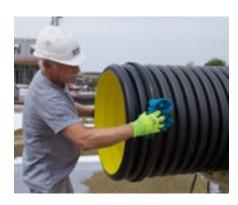
Zur besseren Sichtbarkeit der Schächte während der Bauzeit sollten die Schachtaufsetzrohre über das Planum hinausragen. Die Schachtaufsetzrohre sind mit einer Abdeckung versehen, die das Eindringen von Verfüllmaterial verhindert. Diese ist nicht begehbar bzw. statisch belastbar.
