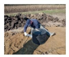
Die Schachtaufsetzrohre können bei Bedarf mit einer feinzahnigen Säge oder einem Rohrschneider mittig im Wellental abgelängt werden.
