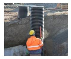
Im Anschluss wird die Doppelsteckmuffe bis zum Anschlag auf den Grundschacht aufgeschoben. Des weiteren wird nun das Schachtaufsetzrohr bis zum Anschlag in die Doppelsteckmuffe geschoben. Im letzten Schritt ist die senkrechte Ausrichtung des Schachtaufsetzrohres zu überprüfen.
