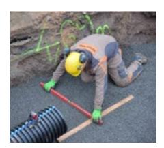
Die Baugrube ist nach den Planungsangaben herzustellen. Es sind die Bestimmungen der DIN 18300 "Erdarbeiten" und DIN 4124 "Baugruben und Gräben" zu beachten. Beim Einbau des Schachtes ist die DIN EN 1610 "Verlegung von Abwasserleitungen" zu beachten.
