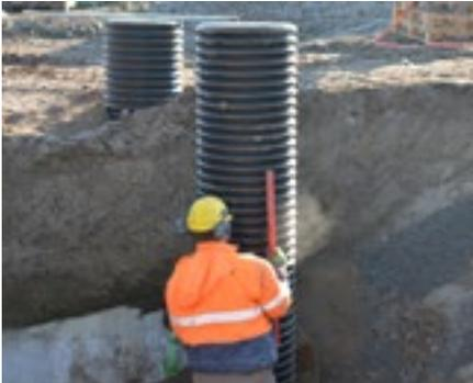
Im Anschluss wird die Doppelsteckmuffe bis zum Anschlag auf den Grundschaft aufgeschoben. Des weiteren wird nun das Schachtaufsetzrohr bis zum Anschlag in die Doppelsteckmuffe geschoben. Im letzten Schritt ist die senkrechte Ausrichtung des Schachtaufsetzrohres zu überprüfen.
