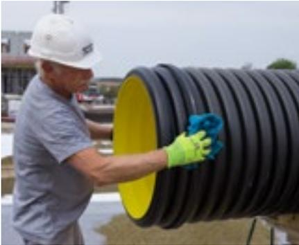
Zur besseren Sichtbarkeit der Schächte während der Bauzeit sollten die Schachtaufsetzrohre über das Planum hinausragen. Die Schachtaufsetzrohre sind mit einer Abdeckung versehen, die das Eindringen von Verfüllmaterial verhindert. Diese ist nicht begehbar bzw. statisch belastbar.
