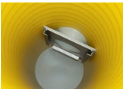
Nun ist zu überprüfen, ob die Führungen und der unteren Anschlagrand der Edelstahlgrundplatte im Schacht frei von Verschmutzung sind, ggf. muss sie mit Wasser gereinigt/abgespritzt werden (Wasserschlauch oder Gießkanne).
