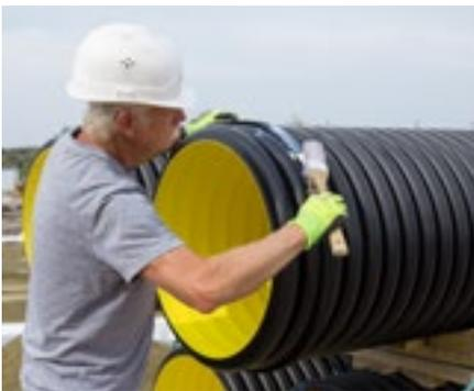
Das Schachtaufsetzrohr wird mit der Doppelsteckmuffe und den beiden Dichtringen auf den Grundschaft aufgesetzt. Dazu sind die Profildichtringe jeweils in das zweite Wellental zu montieren. Nun die Dichtringe und die Innenflächen der Doppelsteckmuffe mit Gleitmittel von FRÄNKISCHE gleichmäßig bestreichen (keine Öle und Fette verwenden).
