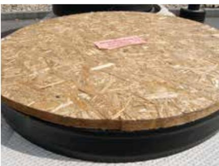
Schutzabdeckung bei Schacht mit Betonabdeckplatte
