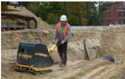
Verdichten der Seitenverfüllung
