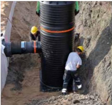
Beispiel: Zielschacht in Verbindung mit Rigofill-Rigole
