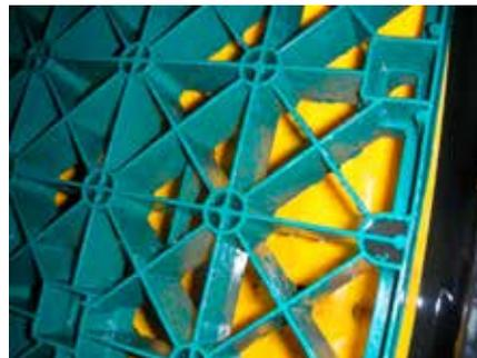
Gereinigte, rückstandsfreie Anlage, hier im Bereich Strömungstrenner
