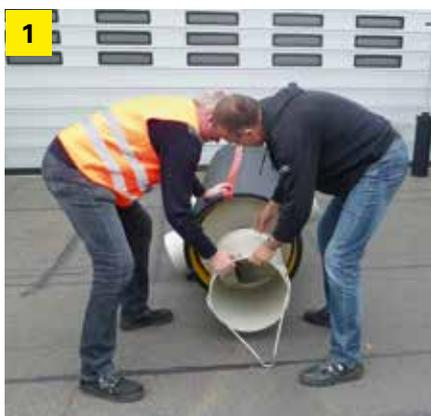
Einsetzen der Sedimentationskassette in den Grundschacht
