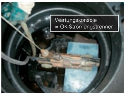
Kontrolle des Spülerfolges mit Dreh-Schwenkkopf-kamera, Kamera auf der Wartungskonsole im Start-schacht einer SediSubstrator basic - Anlage
