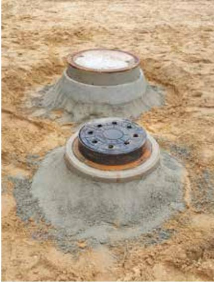
Die Abdeckung des Ablaufsets ist im Set beinhaltet. Für den Transport sowie zum Öffnen und Schließen der Abdeckung dürfen nur geeignete und zugelassene Hebewerkzeuge, Bedienungsschlüssel und Transportmittel verwendet werden.
