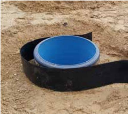
Der BARD-Ring (Betonauflegering Klasse D von FRÄNKISCHE) leitet die Verkehrslasten in das Erdreich ab. Es darf keine direkte Lastübertragung zwischen BARD-Ring und Schacht erfolgen. Die Auflagerfläche des BARD-Ringes ist plan und punktlastfrei herzustellen und muss mindestens ein  $E_{v2}$ -Modul von  $100 \text{ MN/m}^2$  erreichen.
