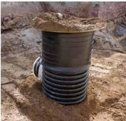
Für die Schachtunterteile und Schachtaufsetzrohre werden Bauzeitenabdeckungen mitgeliefert. Es ist während der Bauzeit darauf zu achten, dass keine Verunreinigungen z.B. durch Verfüllmaterial in die Anlage gelangen. Die jeweiligen Bauzeitenabdeckungen sind erst zu entfernen, wenn die Schachtaufsetzrohre bzw. die Schachtabdeckungen eingebaut werden. Des Weiteren sind die Schachtöffnungen bis zum endgültigen Einbau der Schachtabdeckungen gegen Absturz zu sichern.
