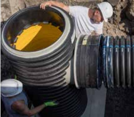
Das zweite Schachtunterteil ist auf das vorbereitete Planum höhengerecht aufzusetzen und gegen montagebedingtes Verschieben zu sichern. Danach ist die Muffenverbindung vorzubereiten und der Schacht auf das Sedimentationsrohr zu schieben.
