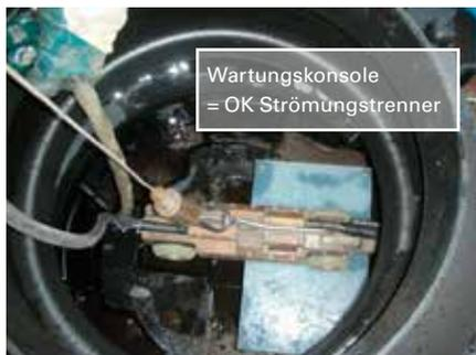
Kontrolle des Spülerfolges mit Dreh-Schwenkkopf-kamera, Kamera auf der Wartungskonsole im Startschacht einer SediSubstrator L - Anlage
