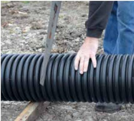
Die Schachtaufsetzrohre sind so zu kürzen, dass sie im Bereich des Auflageringes enden. Die Rohre sind mit einer feinzahnigen Säge oder einem anderen geeigneten Werkzeug mittig im Wellental und senkrecht zur Rohrachse abzulängen.
