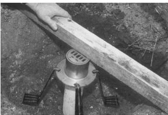
Die WALU-Endkappe mit montierten Ankern wird auf das aufsteigende Rohr gesteckt. Mittels Richtlatte wird die endgültige Höhe eingerichtet.
