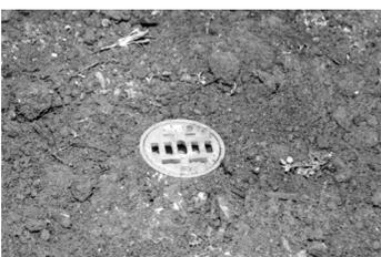
Nach dem restlichen Verfüllen und Ebnen entsteht auch ohne befestigte Oberfläche ein sauberer und fest verankerter Anschluss.
