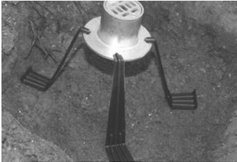
Die WALU-Anker werden zunächst in alle 4 Bohrungen eingehakt. Ca. 28 cm unter dem geplanten Oberflächenplanum wird eine ebene Fläche hergestellt.
