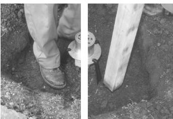
Durch sorgfältiges Verdichten, z.B. Festtreten oder Stampfen, wird die spätere Auszugsicherheit verbessert.
