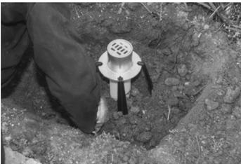
Zunächst sollte bis zur Hälfte verfüllt werden. Dabei ist auch auf den Raum zwischen Rohr und Anker zu achten.
