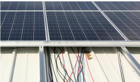
Leitungen von Solar- und Photovoltaikanlagen sind jahrzehntelang unterschiedlichen Beanspruchungen wie UV-Strahlung, Witterung, mechanischer Belastung, aber auch Nagetierbissen und Insektenbefall ausgesetzt.
