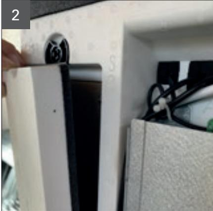
EPS Abdeckung Wärmetauscher entfernen.
