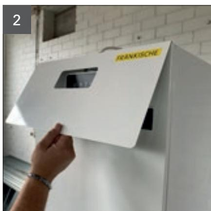
Filterabdeckung etwas anheben und nach oben abheben.
