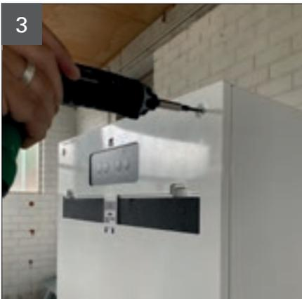
Die beiden Befestigungsschrauben (Torx TX 20) der Frontblende lösen.
