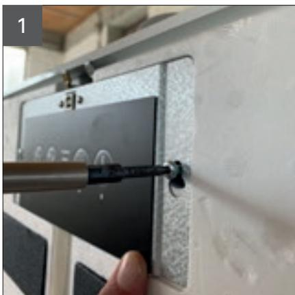
Die zwei Befestigungsschrauben (TX20) etwas lösen.
