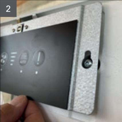
Bedieneinheit etwas nach oben schieben und abheben.
