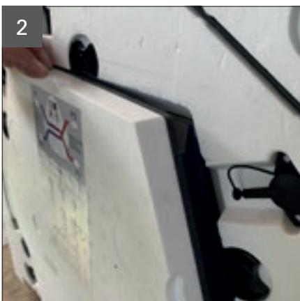
EPS Abdeckung Wärmetauscher entfernen.
