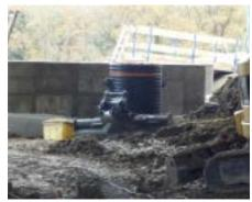
Im Bereich der Schlichemtalbrücke auf der A 81 Stuttgart-Singen, Streckenabschnitt AS Oberndorf und AS Rottweil (Betriebs-km 657+100 bis 657+400), wird Regenwasser gefasst, um es der Regenwasserbehandlung zuzuführen.
