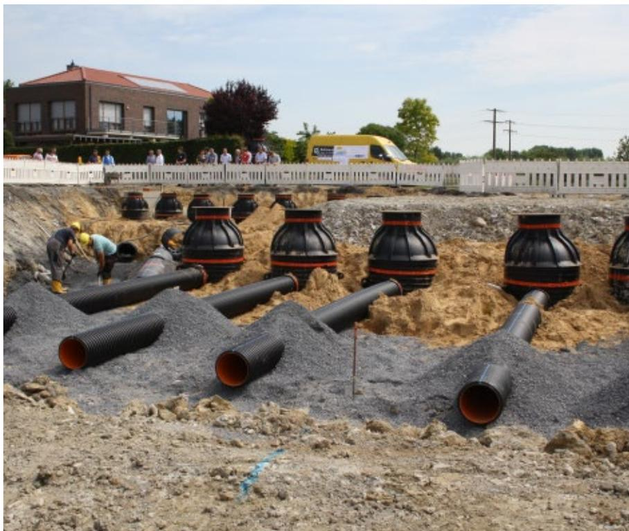
FRÄNKISCHE lieferte die sieben SediPipe XL-Anlagen bereits vorgefertigt zur Baustelle, sodass sie innerhalb kürzester Zeit eingebaut werden konnten.
