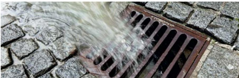
Einschlägige Regelwerke stellen daher eindeutige Anforderungen an die Reinigung von belasteten Regenabflüssen. So fordert z. B. das DWA-Arbeitsblatt A 138, bei der Versickerung von Niederschlagswasser den Boden- und Gewässerschutz unbedingt zu berücksichtigen. Grundlage für die Auswahl der Behandlungsanlage ist häufig das DWA-Merkblatt M 153.
