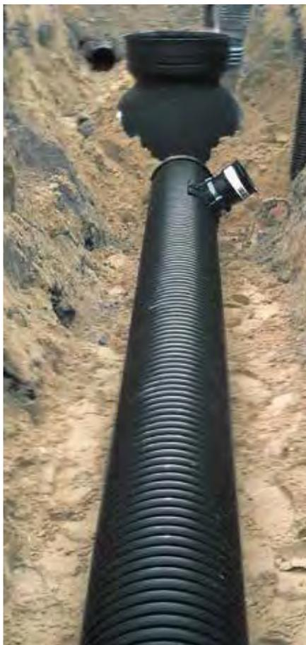
Le remblaiement et le compactage doivent être réalisés conformément aux préconisations du fascicule 70 et au guide du SETRA "Remblayage des tranchées et réfection des chaussées".
