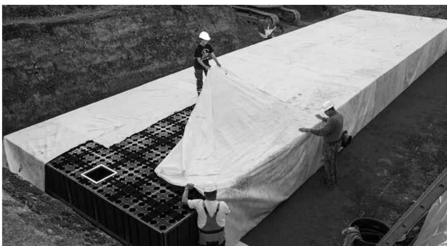
Les ouvrages Rigofill ST-B doivent être entièrement emballés dans du géotextile. Aux extrémités, prévoir des longueurs suffisantes de chevauchement (au moins 30 cm) afin d'éviter toute pénétration de remblai dans l'ouvrage. Garantir l'étanchéité des entrées en découpant le géotextile en croix.
