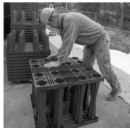
L'assemblage doit être effectué à l'intérieur de la fouille.
